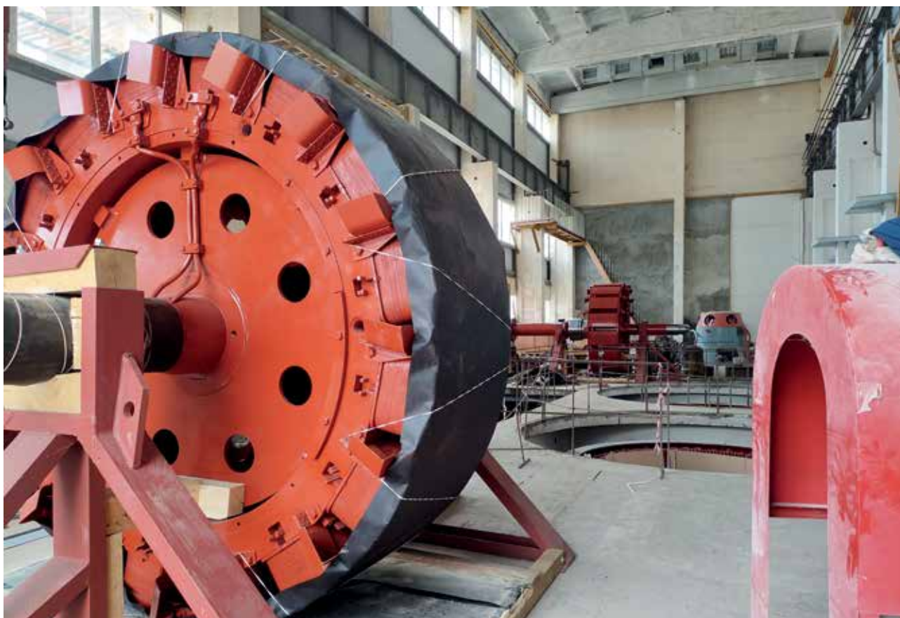
Подготовка к монтажу статора основного насосного агрегата №3
