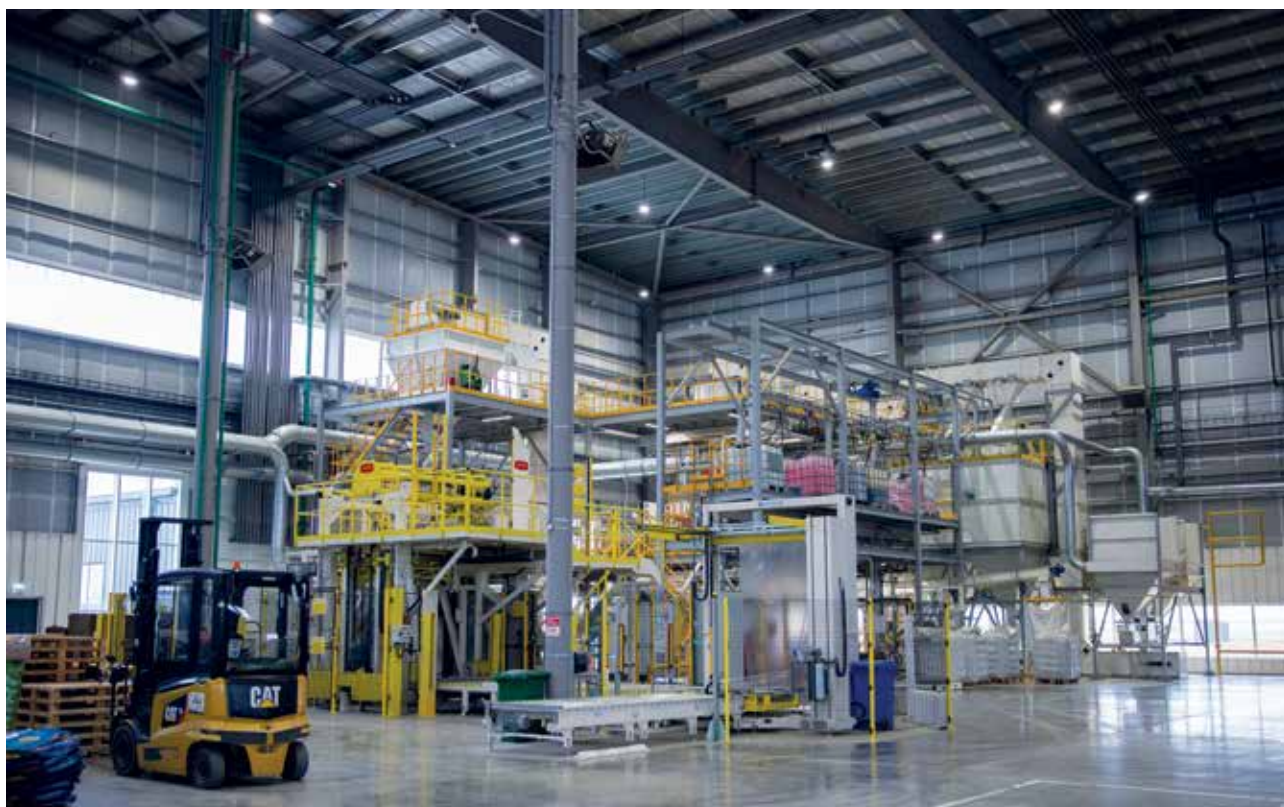
Производственный цех завода «Танаис», г. Павловск, Воронежская область
